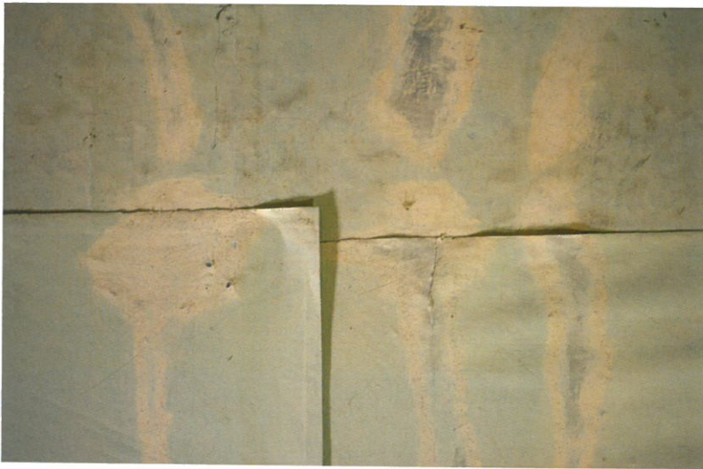
7 Detail auf der Nordwand: abgelöste Bereiche sowie Wasserränder und „verlorene“ Retuschen vor der Restaurierung, Aufn. 2018.
